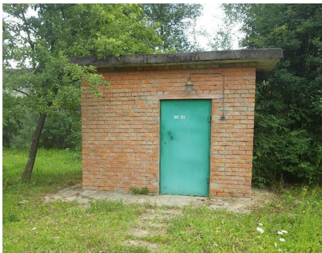
Рисунок 18. Надземный павильон скважины № 21
