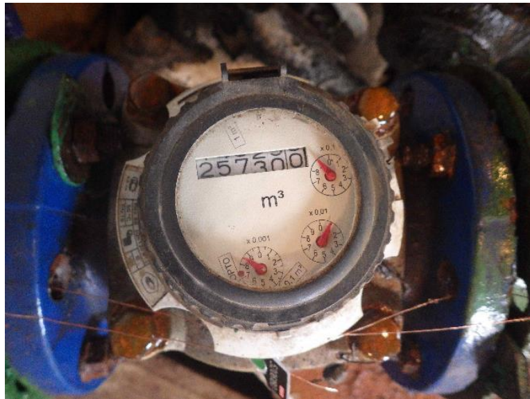
Рисунок 35. Прибор учёта поднятой воды на скважине № 49 ВЗУ № 20
