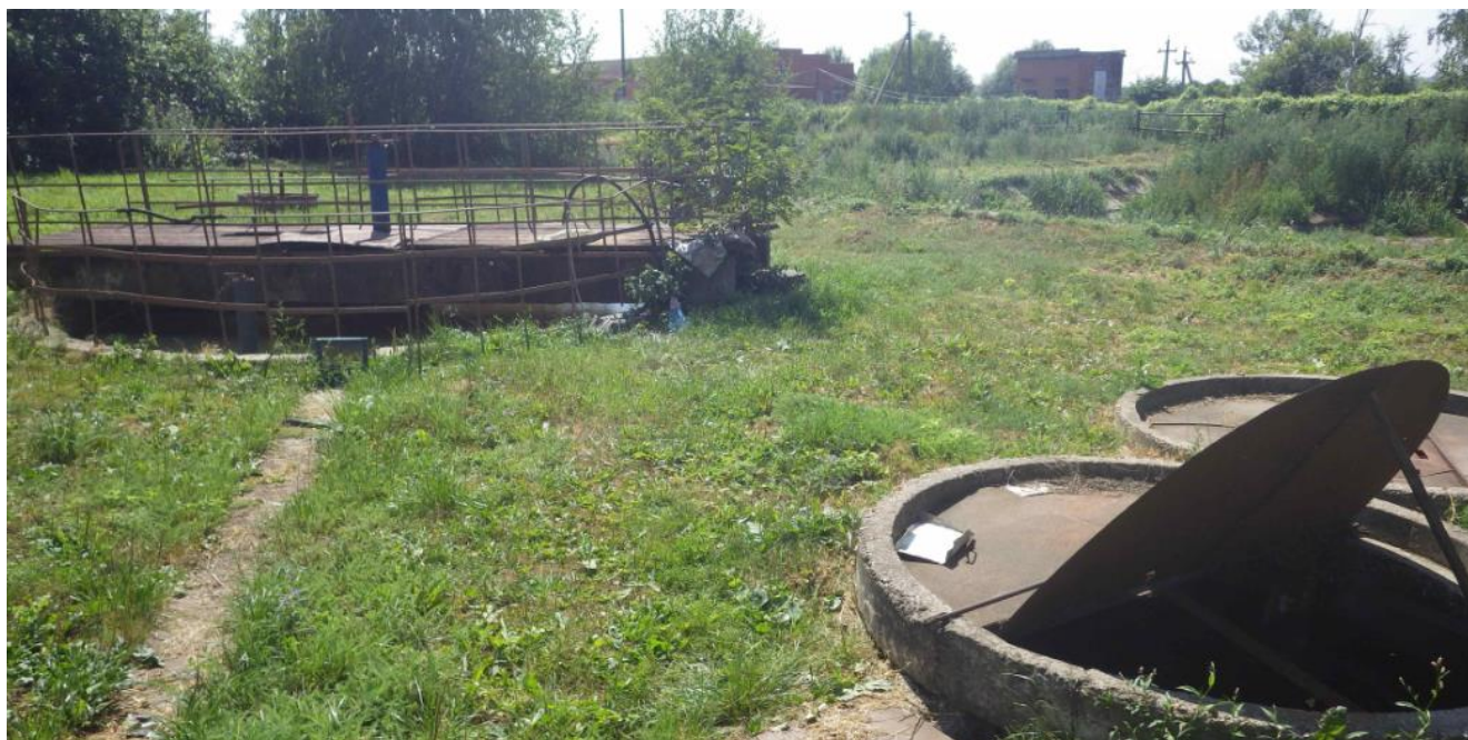
Рисунок 56. Вертикальный отстойник
