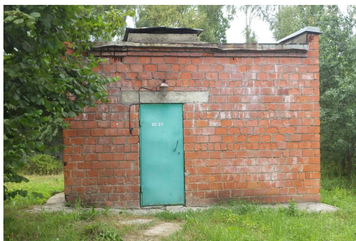
Рисунок 21. Надземный павильон скважины № 35
