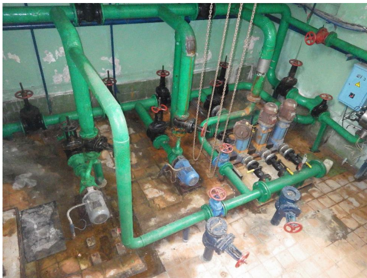
Рисунок 23. Машинный зал станции второго подъёма
