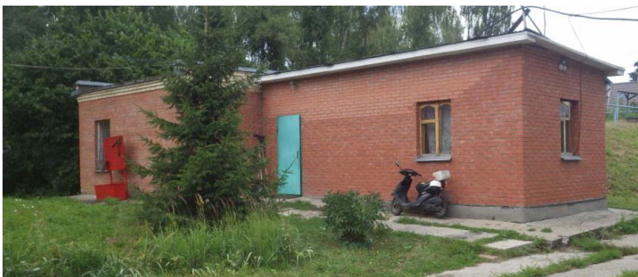
Рисунок 22. Здание насосной станции второго подъёма
