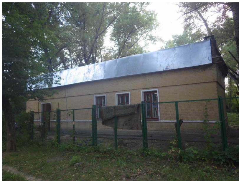
Рисунок 29. Здание насосной станции второго подъёма
