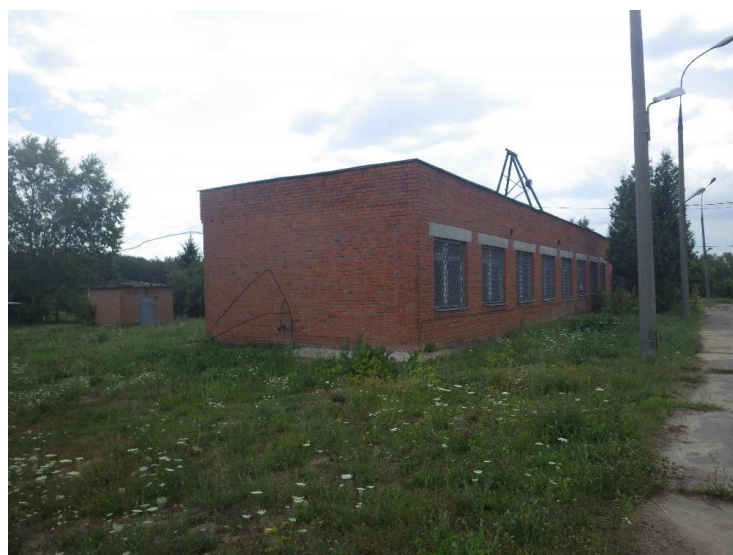
Рисунок 14. Внешний вид здания насосной станции 2 подъёма
