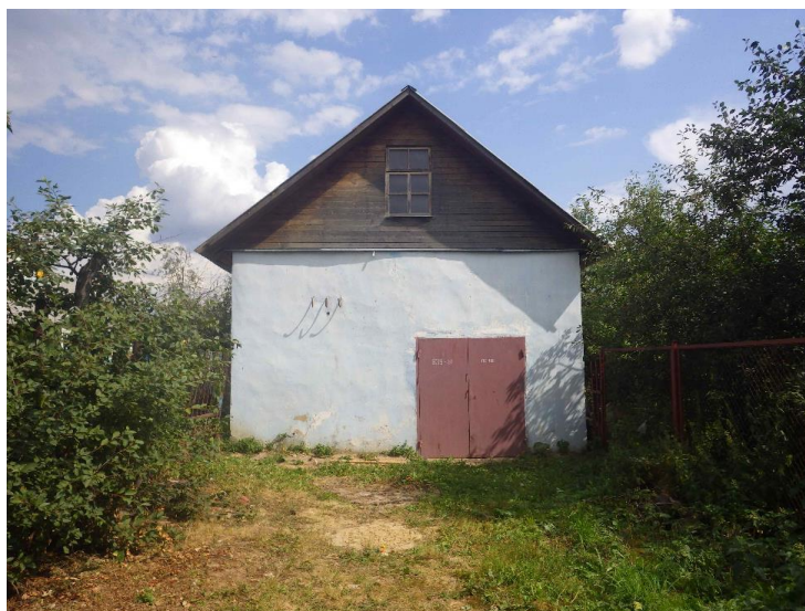
Рисунок 25. Надземный павильон скважины № 48
