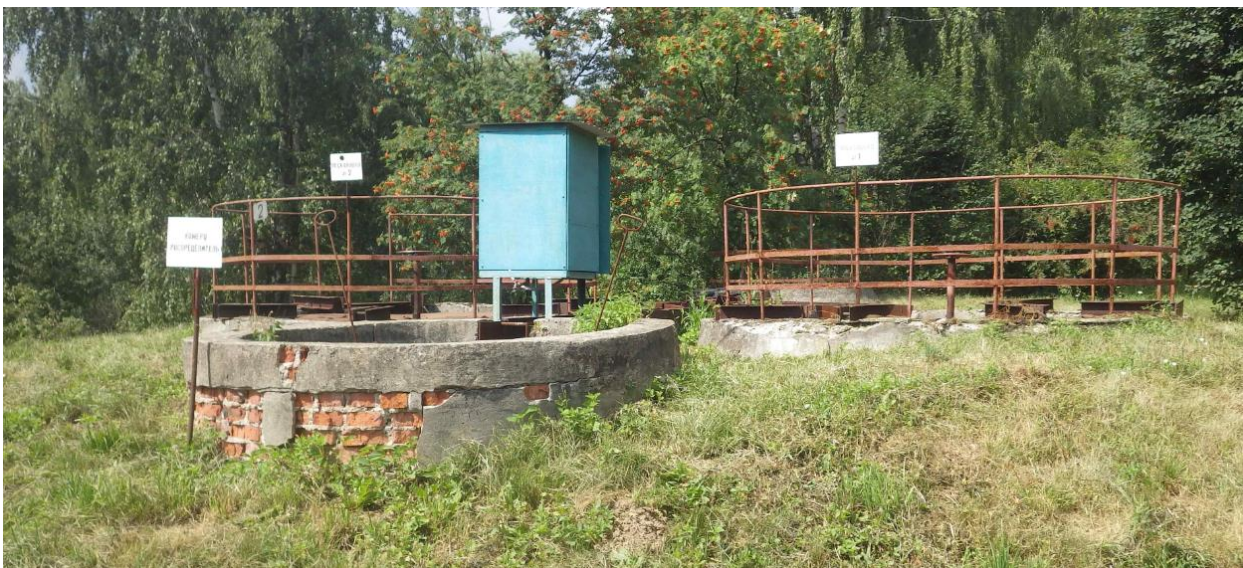
Рисунок 45. Песколовки и распределительная камера
