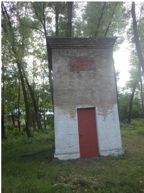
Рисунок 28. Надземный павильон скважины №1
