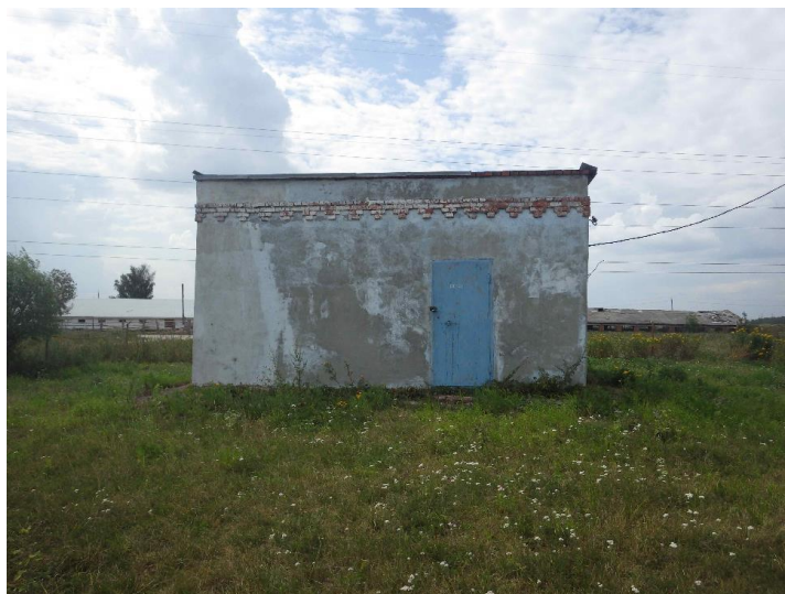
Рисунок 26. Надземный павильон скважины № 49
