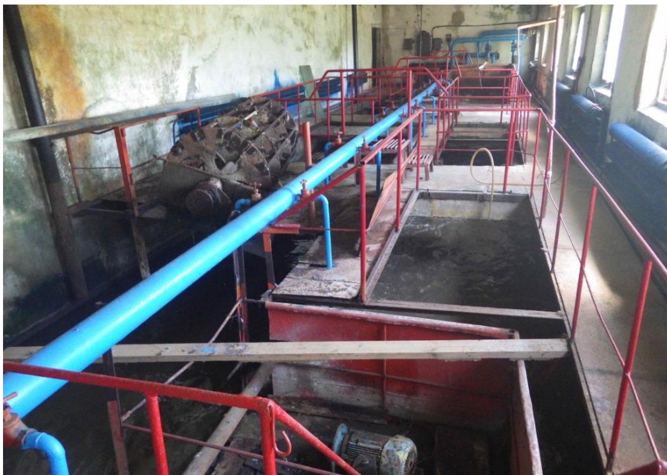
Рисунок 57. Аэротенки
