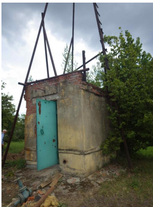
Рисунок 19. Надземный павильон скважины № 21а
