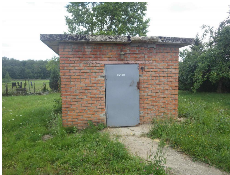
Рисунок 13. Надземный павильон скважины № 6
