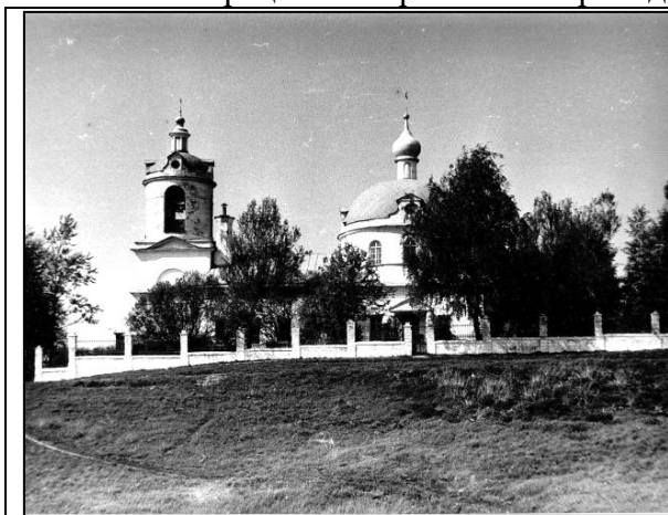
Церковь Никольская. Общий вид с юго,
