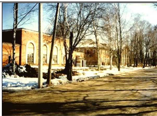
Памятное место "Бутовский полигон". Здание котельной и жилой дом по Юбилейной улице, фото 1996 г.
