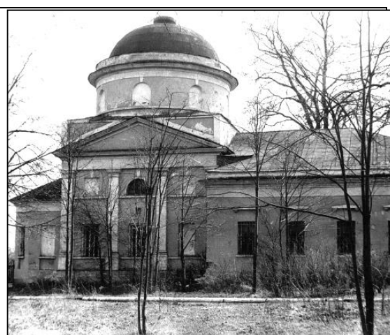
Церковь Казанской иконы Божией Матери. Северный фасад, фото 1979 г.
