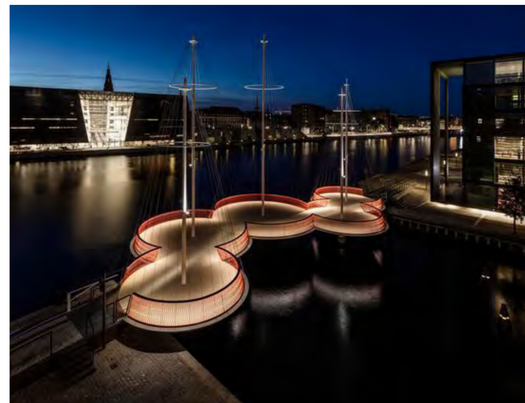
Подсветка площадок на воде
